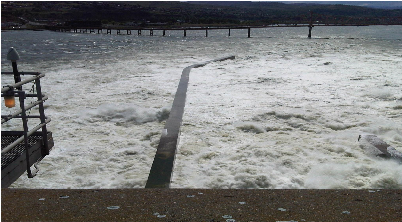
Spillwall overview at 200K spill
